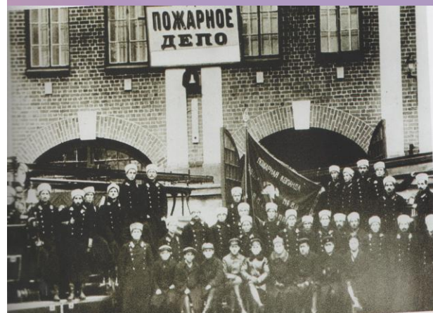
НОВОЕ ПОЖАРНОЕ ДЕПО, 1926 год постройки
